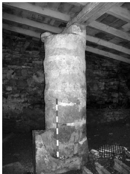
Figures 8 i 9. El cup del molí de Can Granot i dovelles del cup reaprofitades en altres parts de la casa
