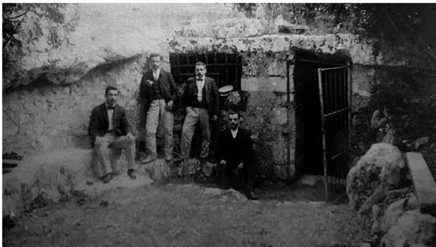
Reixat que barrava l'entrada a les coves.
