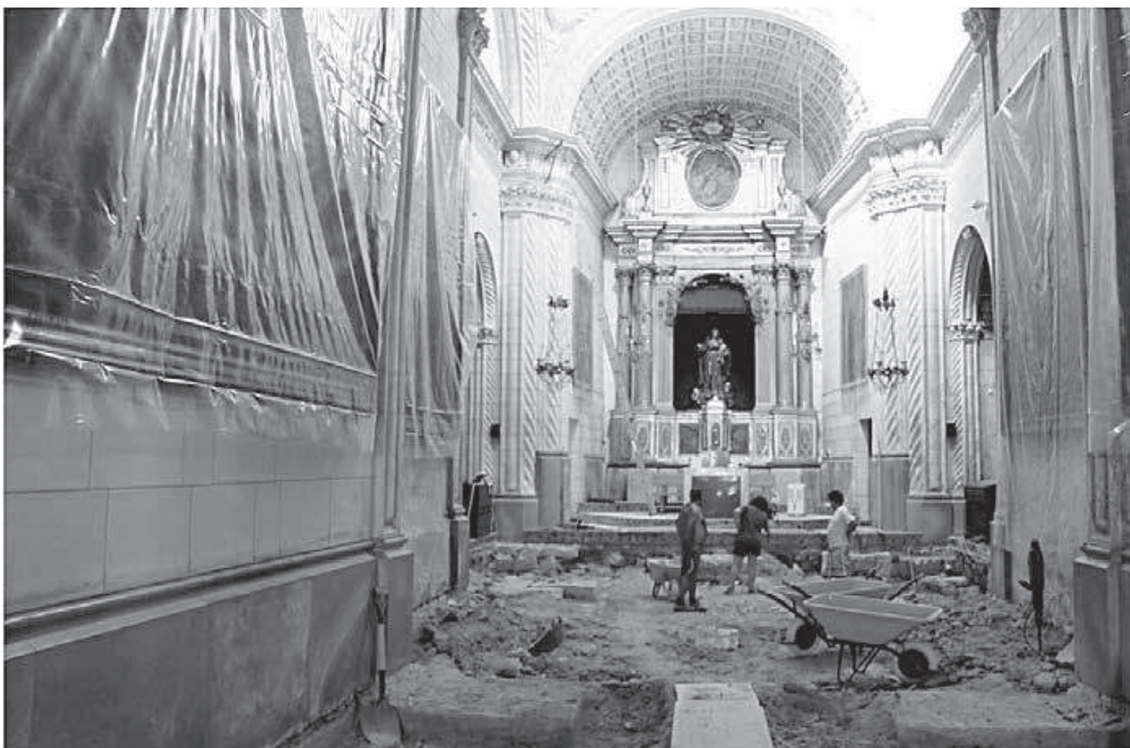
Capella del Roser. Estat actual després d'aixecar el subsòl.
