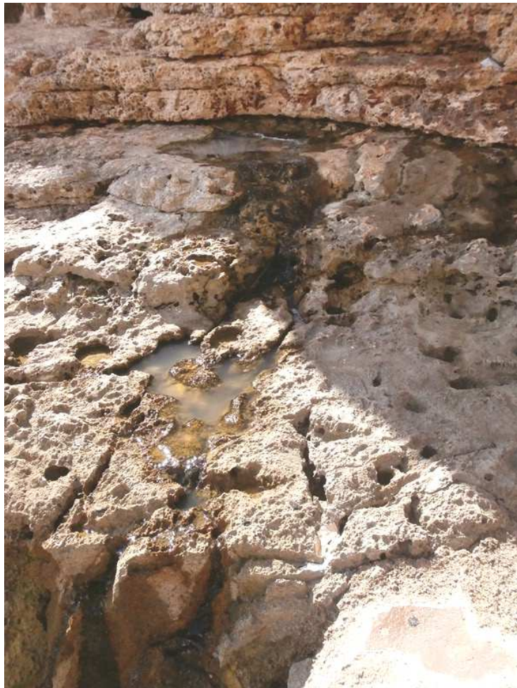
Foto 6 – Vista d'un dels punts de vessament d'aigües fecals al penya-segat
